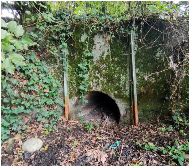
A gauche : ouvrage exutoire de l'étang inopérant et inadapté pour contrôler les niveaux d'eau, prévu de restaurer dans le cadre du programme. A droite : exemple de végétation rivulaire déséquilibrée nécessitant la reconstitution d'une ripisylve © Progeo-Environnement.
