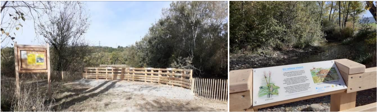
Ponton semi-circulaire et panneau intégré dans le garde-corps © RNR.
