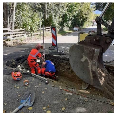
Début d'installation d'une traversée. On perçoit l'impact sur la circulation et la dangerosité pour les ouvriers malgré les précautions prises © RNR.
