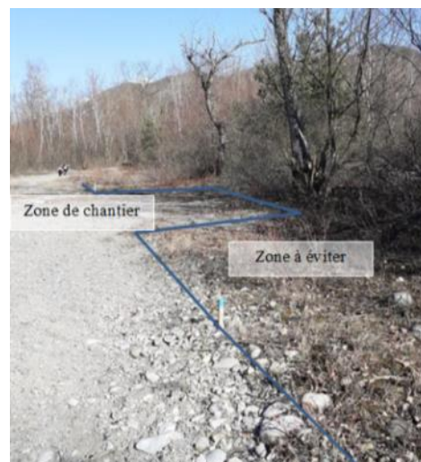
Marquage du chantier en rive droite (© Grenoble-Alpes Métropole, RNR).
