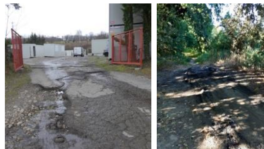
A gauche, écoulements depuis une entreprise vers le périmètre de protection. A droite, dégâts après enlèvement d'un véhicule incendié.
